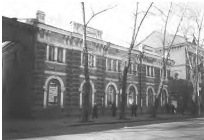
Рис. 19. Здание Иркутского ТФК на ул. К. Маркса
